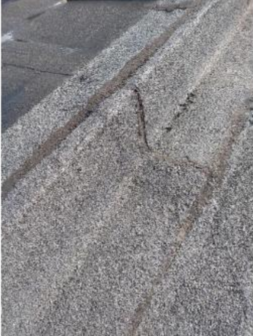
Photos étanchéité des relevés apparents
