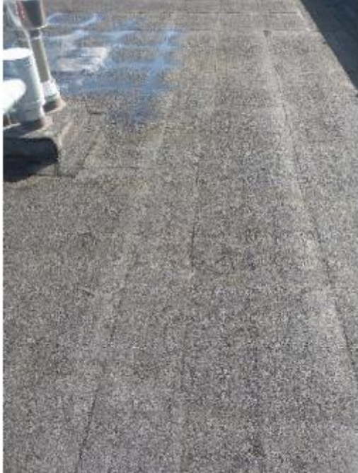
Photos étanchéité partie courante apparente
