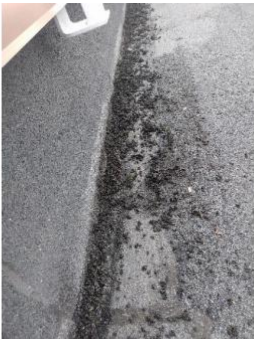
Photos avant nettoyage
