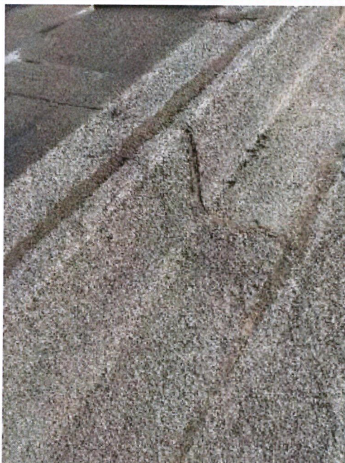
Photos étanchéité des relevés apparents
