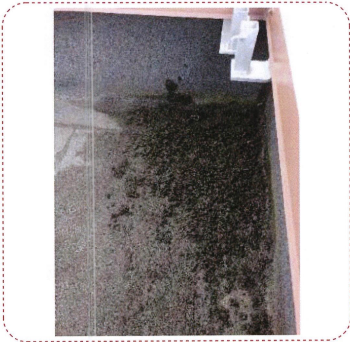
Photos avant nettoyage
