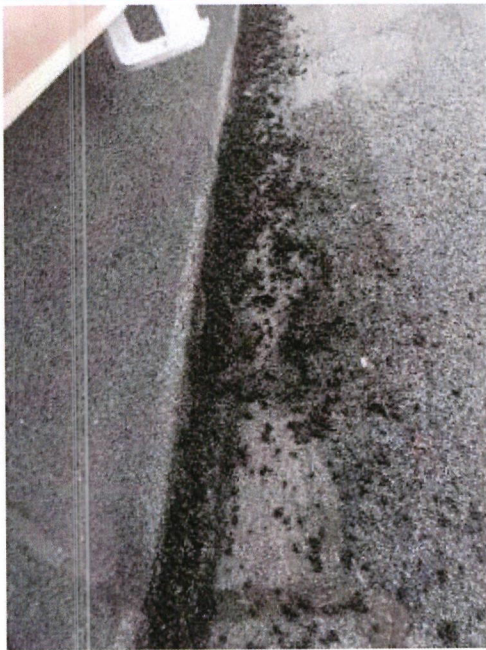
Photos avant nettoyage
