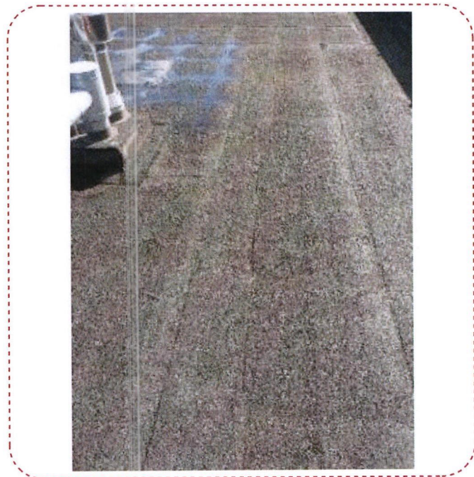
Photos étanchéité partie courante apparente
