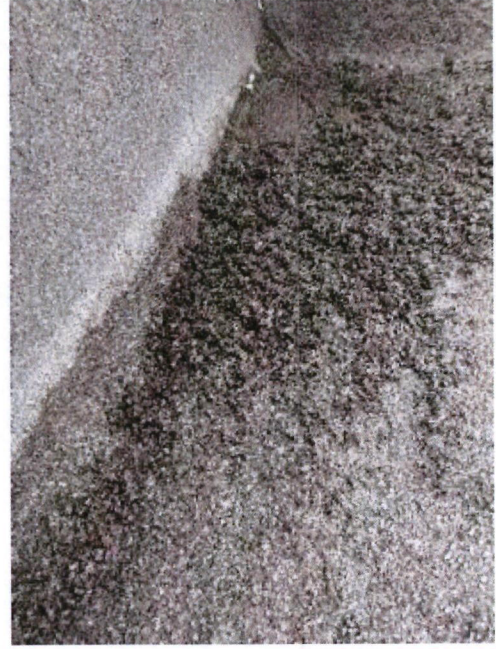
Photos avant nettoyage
