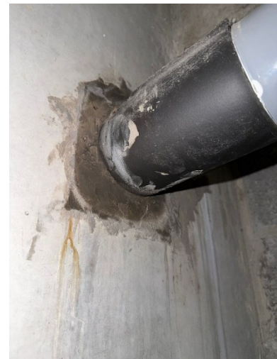
Création de l'étanchéité
