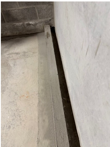
Batardeau au fond d'un box
