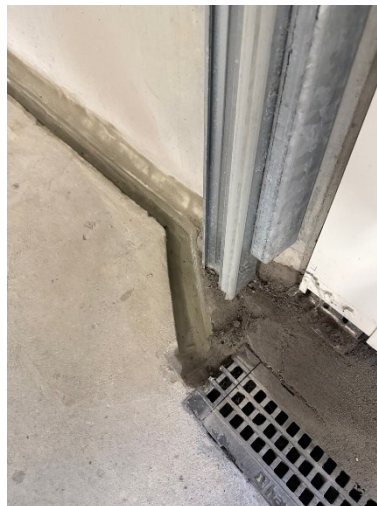
Création de l'évacuation
