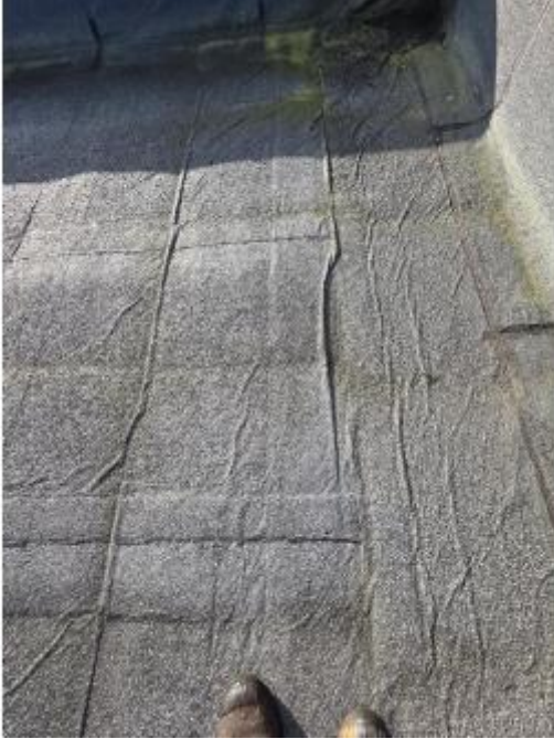
Photos étanchéité partie courante apparente sur 7m
