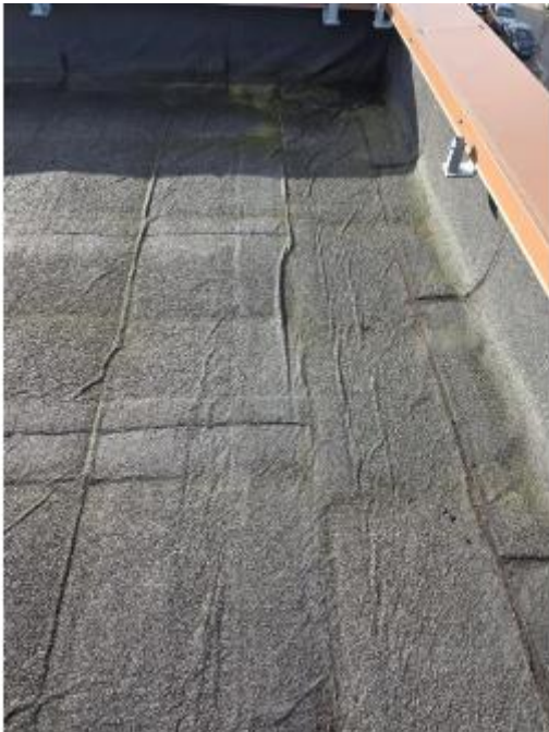
Photos points singuliers Présence de plis en partie courante
