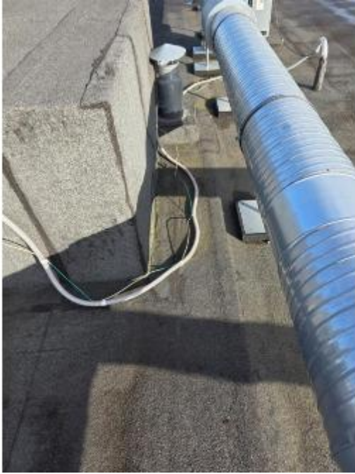
Photos après nettoyage
