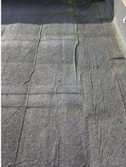
Photos protection toiture
