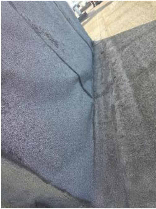
Photos étanchéité des relevés apparents - Nous constatons un décollement de l'étanchéité au niveau de l'édicule.
